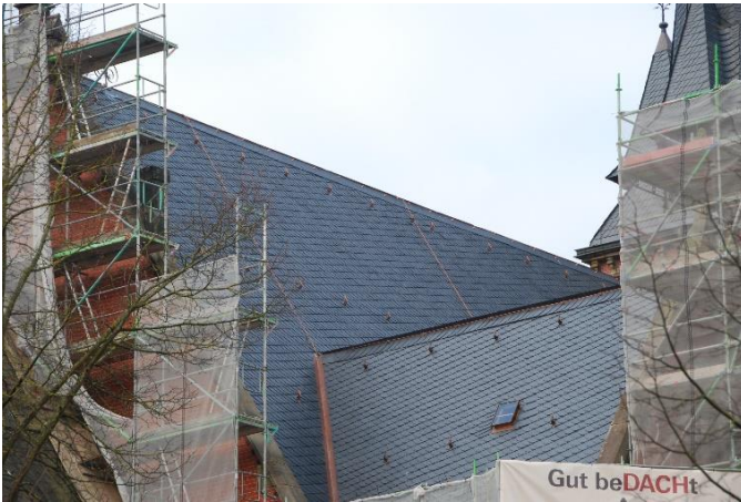
Ein Teil des erneuerten Daches an der Nordseite unserer Kirche.
